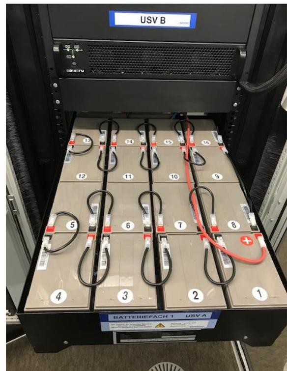
36 x 12 Ah Autonomie: 30 Min. bei 5 kW Last
