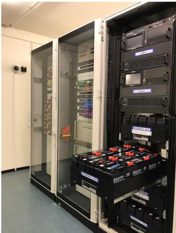
36 x 18 Ah Autonomie: 60 Min. bei 5 kW Last
