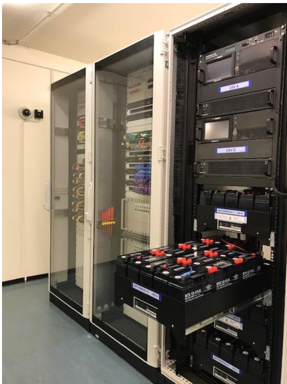
36 x 18 Ah Autonomie: 60 Min. bei 5 kW Last
