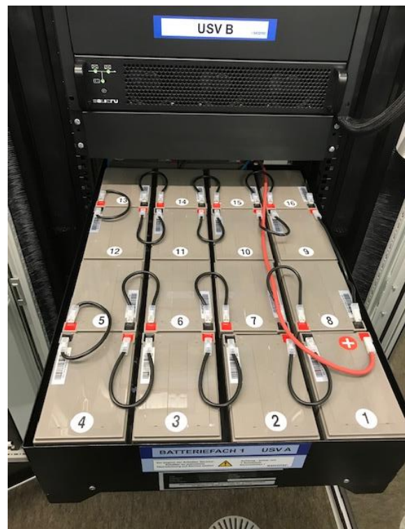
36 x 12 Ah Autonomie: 30 Min. bei 5 kW Last
